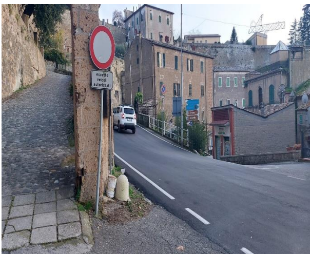
7 altezza civico 7 di Strada 27 provinciale Pitigliano - Sorano
