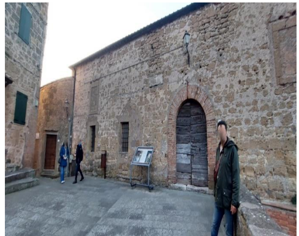
47 Edificio del Cortilone
