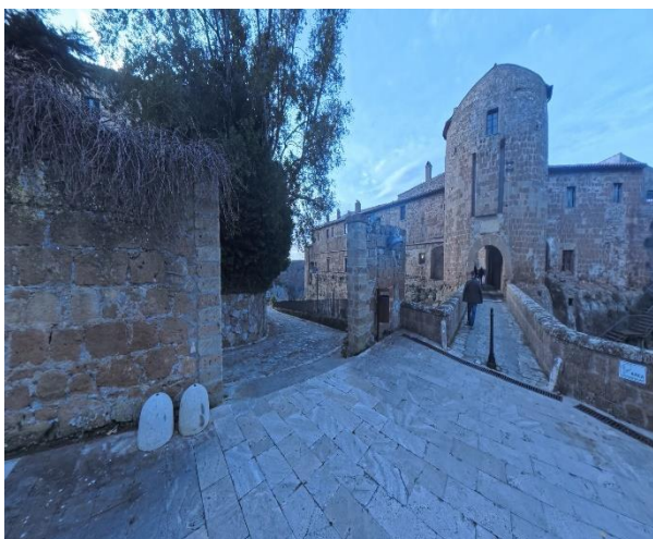
9 area interna fortezza
