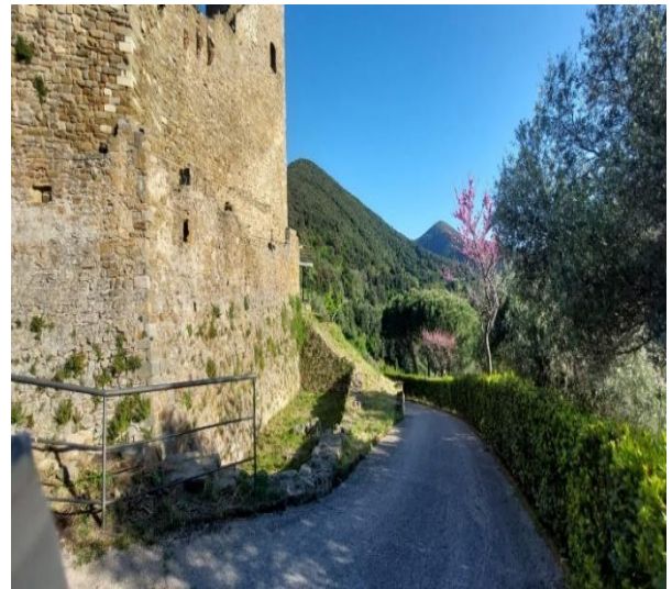
49 ultimo tratto della rampa in asfalto
