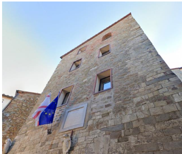
13 Palazzo Comunale, tessitura muraria originale
