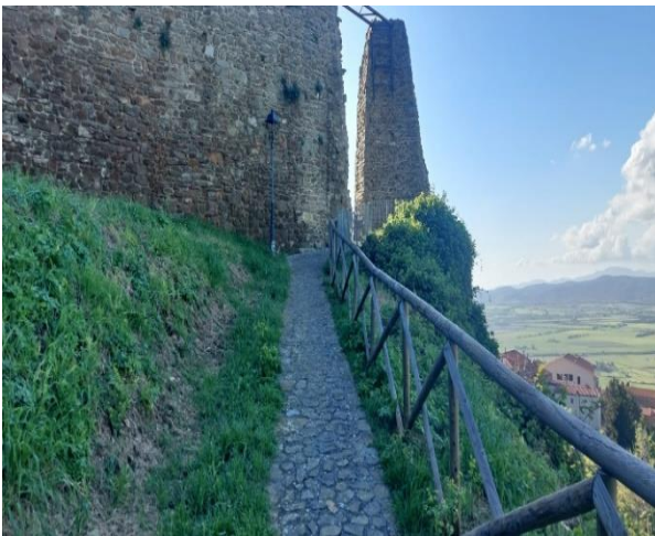
40 Rampa per raggiungere la terrazza panoramica
