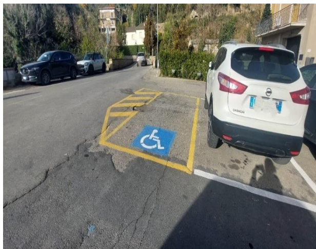
1 Parcheggio riservato Via S. Chiara
