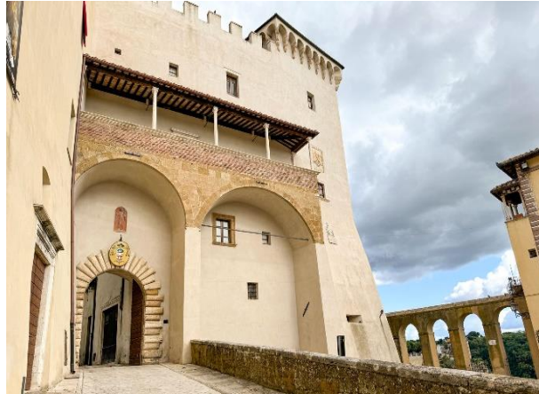
35 Portale di ingresso esterno
