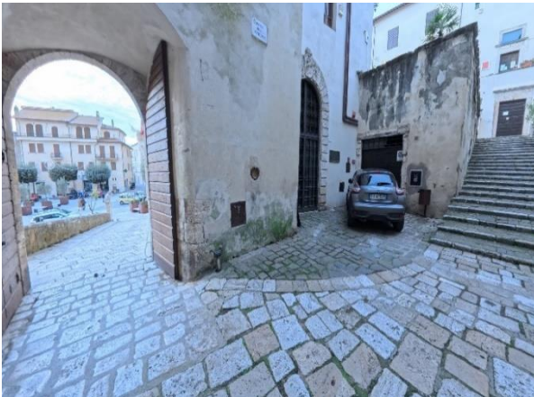
36 Portale di ingresso interno e rampa
