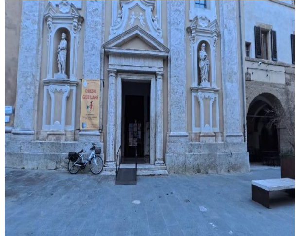
81 rampa di accesso
