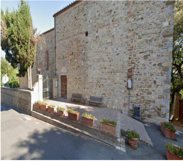
51 Rampa ingresso Chiesa santa Maria13
