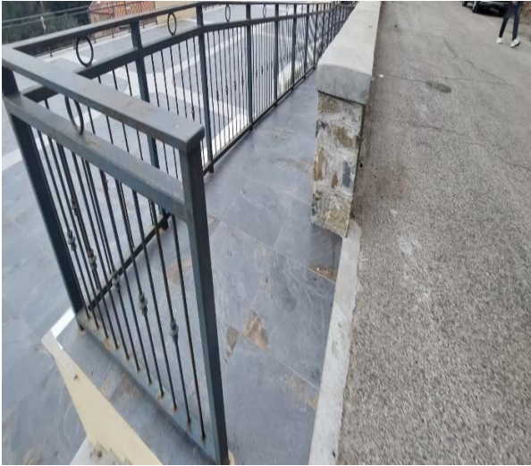
3910 Varco ingresso rampa Terrazza
