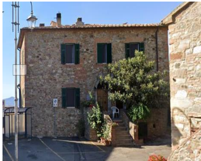
3 Strada Provinciale Campagnatico, dopo Vicolo di Bellaria
